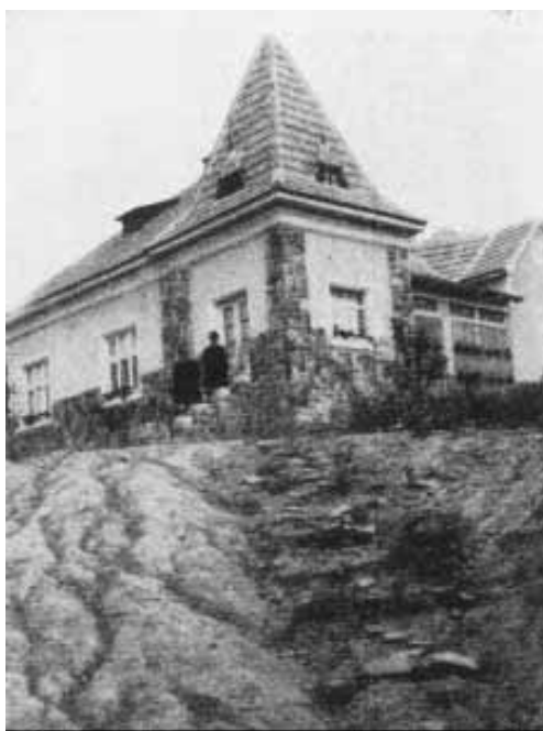
Csőváry Dezső háza, beépített méhessel, Kétdobonyban.
