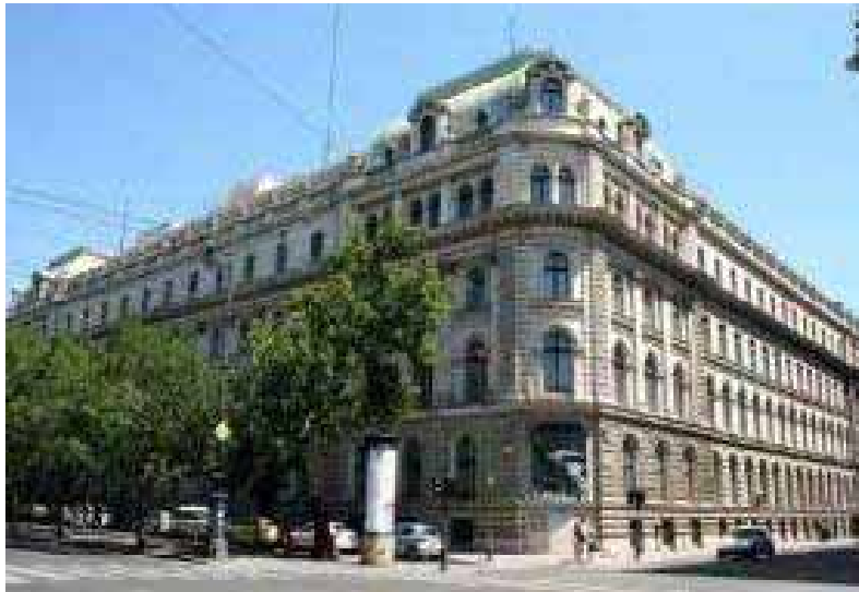
A Közlekedési és Postaügyi Minisztérium I. Vasúti Főosztály MÁV Vezérigazgatóság épülettömbje. Budapest, Népköztársaság út 73-75
