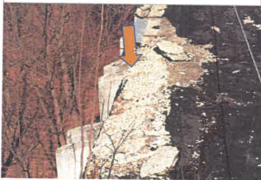
Levált, hiányzó szegély lemez a vizet nem tudja elvezetni az épülettől. A víz így szabadon hömpölyög az oldalfalon. Téli időszakban a beton felfagyását okozva.
