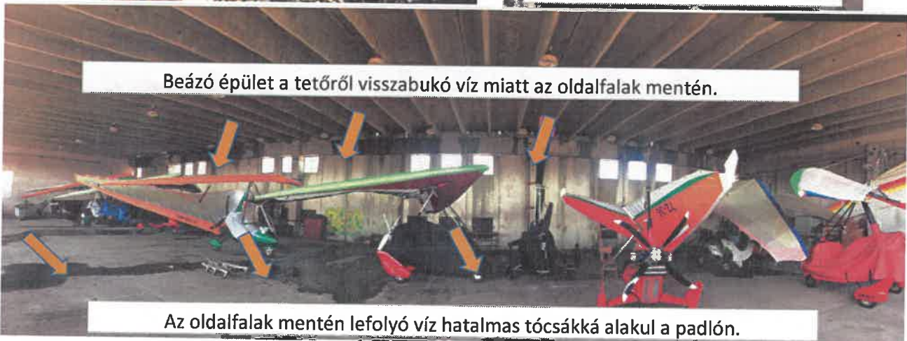
Felvált szigetelés a teljes tetőfelületen.
